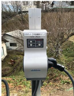
営業車をEV車とPHV車に切り替え、V2H (Vehicle to Home) の充放電設備を採用しました。(第1工場既設の太陽光発電)
